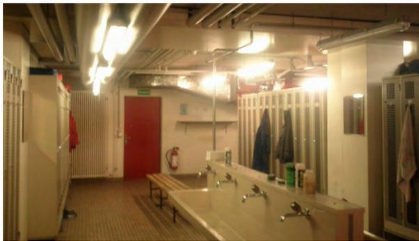
**Energie sparen durch Bewegungsmelder:** «Wir bauen in unserer Firma Bewegungsmelder in die Garderoben ein. Das Licht wird nach 10 Minuten automatisch ausgeschaltet. So kann die Brennzeit von ca. 12 Stunden auf etwa 3 Stunden pro Tag reduziert werden. Energiespar-Potential pro Jahr: 2'275 kWh!»
