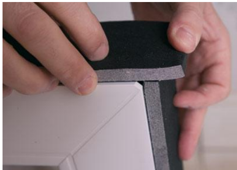
Symbolbild: Montage Fensterdichtung
