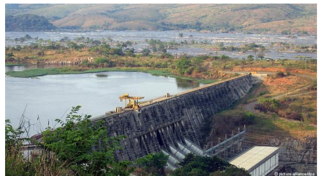
Abbildung 19: Wasserkraftwerk Inga 1 am Kongo www.dw.de/
