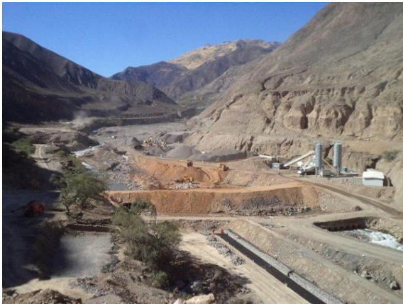
Abbildung 20: Baustelle des Wasserkraftwerkes Cheves in Peru www.hochtief.de
