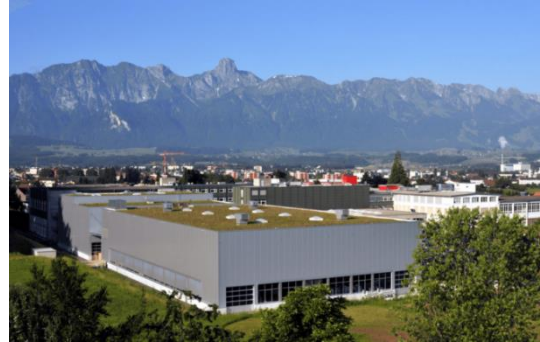
Abb. 1; Studer Gelände mit 800 Arbeitsplätzen
