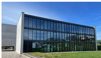
Face Est bâtiment D
