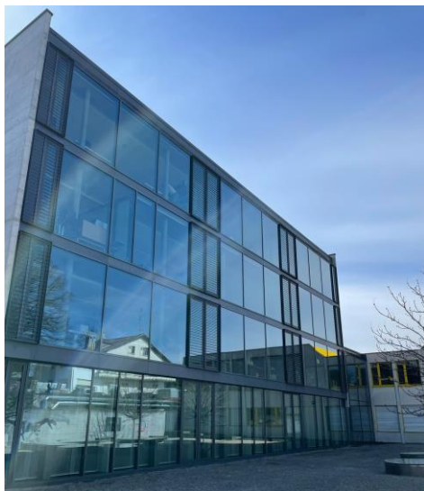
Face Nord bâtiment C
